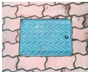
Pojezdový poklop – nosnost 12,5 t
