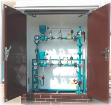
RESO v prefabrikovaném objektu
