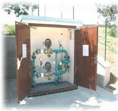
RZTD 3 v prefabrikovaném objektu
