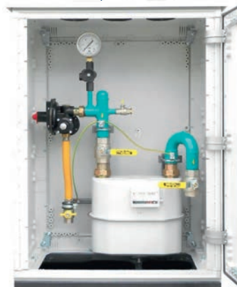
RZTM 3 s regulátorem R/71 v plastové skříni
